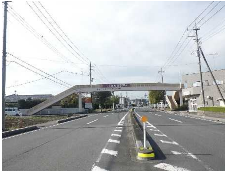
写真 3-3 泉小学校歩道橋
