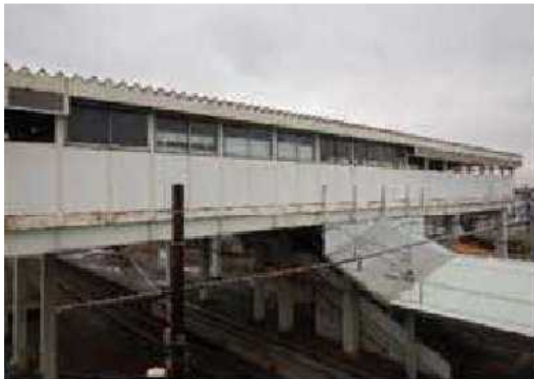
写真 3-1 行田市駅跨線橋
