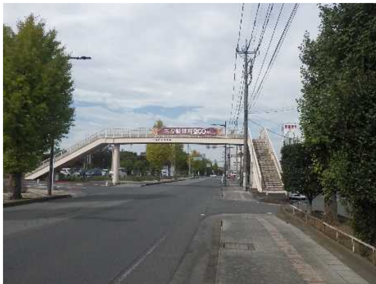
写真 3-4 ときわ通歩道橋
