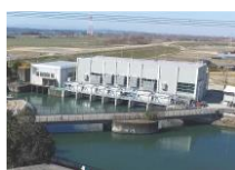
糠田排水機場
