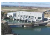
糠田排水機場
