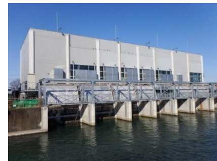
糠田排水機場
