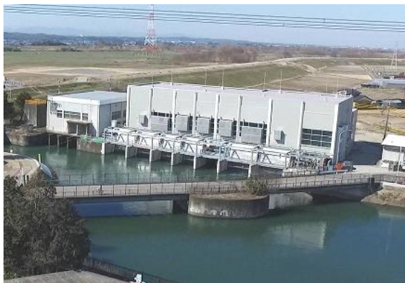
糠田排水機場
