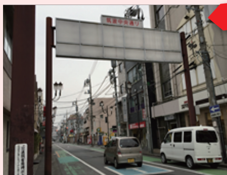
撤去されずに残されたアーチ看板
