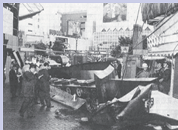
台風で落下した時の様子
