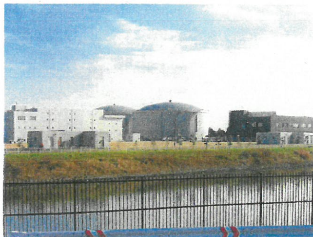
県営行田浄水場
