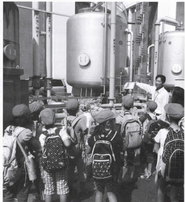
②井戸からくみ上げた水を飲み水にする「ろ過機」(向町浄水場)
