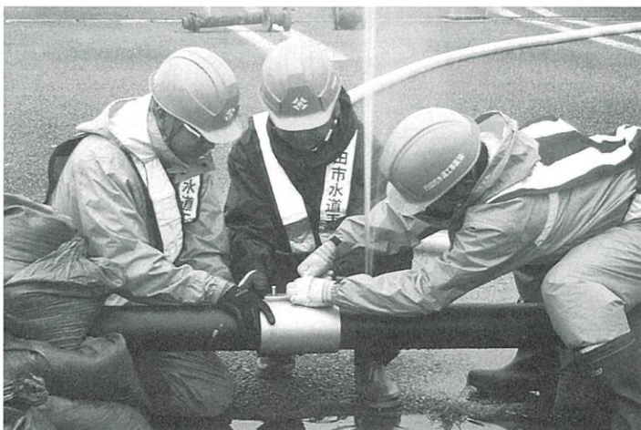
水道本管の復旧訓練
