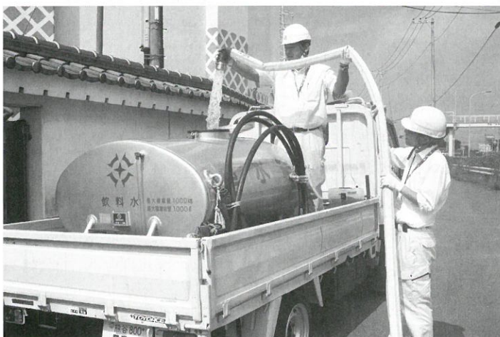
①配水タンクから給水車へ水を補給
