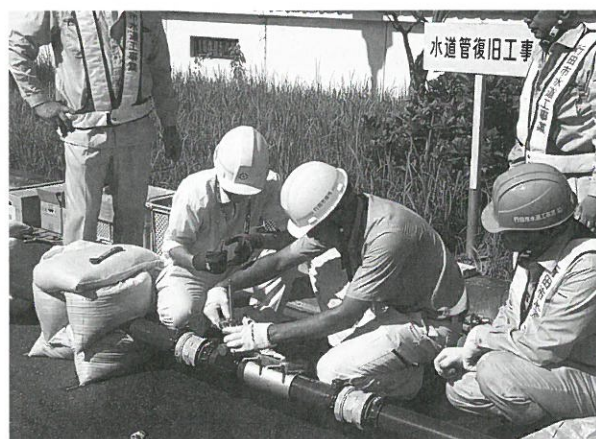
③水道本管の漏水修繕訓練
