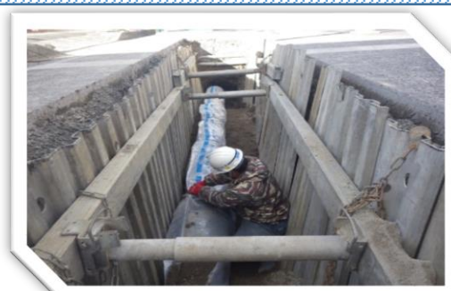
水道管の耐震化工事
