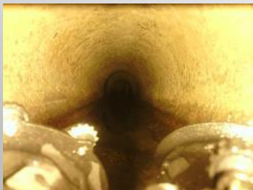
管内TVカメラ調査実施状況
