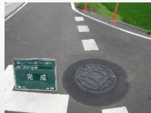
マンホール蓋交換後
