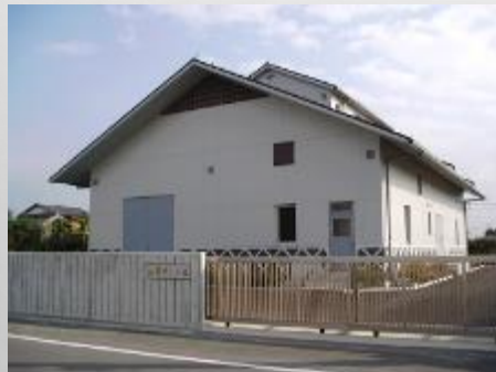
城西ポンプ場
