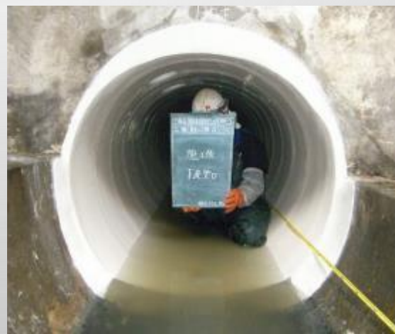
管路更生状況
