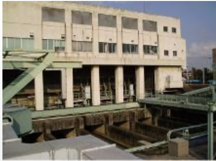
緑町ポンプ場（第1施設）
