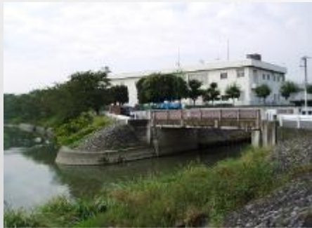
谷郷ポンプ場
