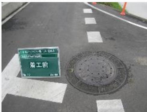
マンホール蓋交換前
