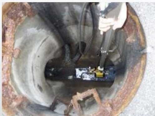
マンホール点検実施状況
