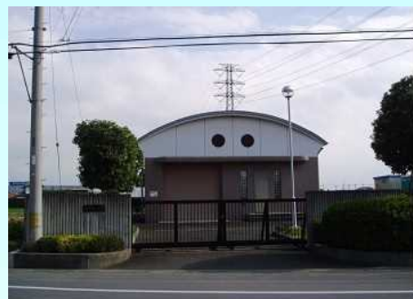
③東谷ポンプ場
