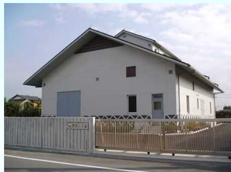
⑤城西ポンプ場
