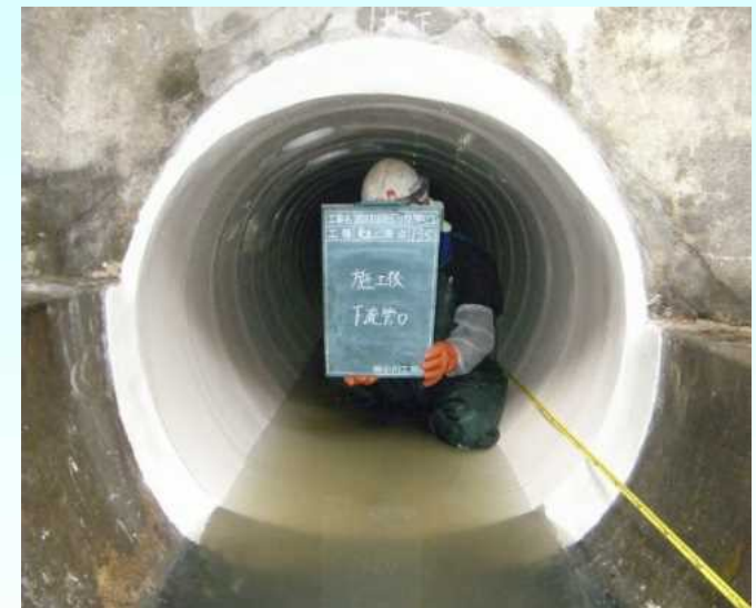
管路更生状況
