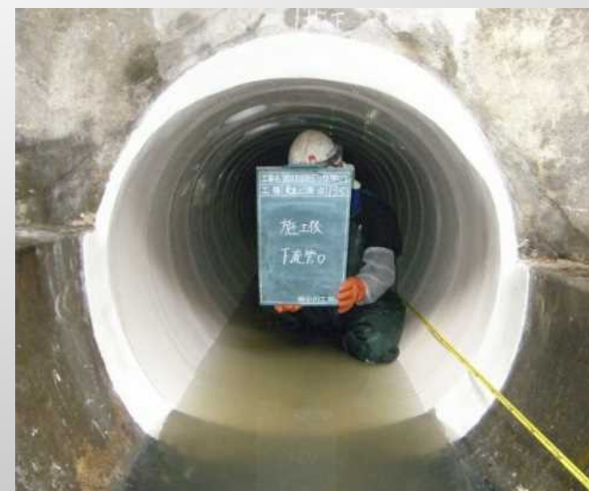
管路更生状況
