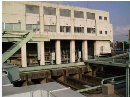
緑町ポンプ場（第1施設）
