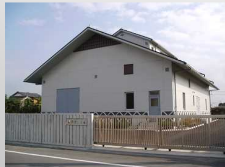
城西ポンプ場
