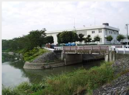
谷郷ポンプ場
