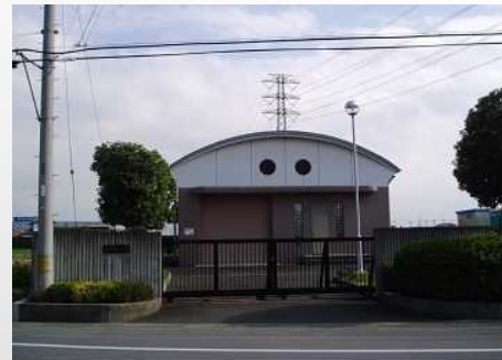
東谷ポンプ場
