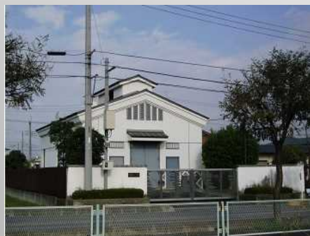
棚田ポンプ場
