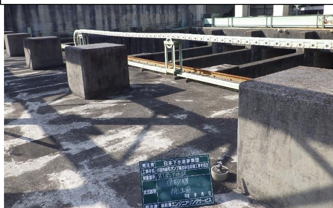
アルミフェンス設置前
