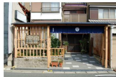
▲しゅん工（正面）
