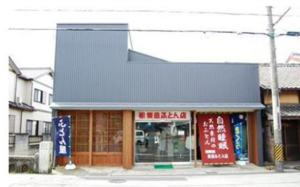
▲しゅん工（正面）
