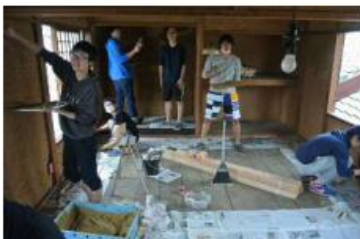
▲内部も自分たちの手で改修
