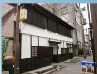
長野県松本市（前面改修）
