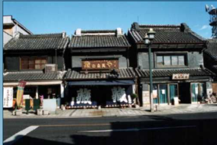
栃木県栃木市（改築）
