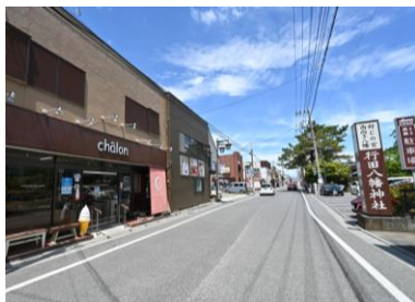
まち並み景観形成先導モデル事業として修景整備等が行われた八幡通り
