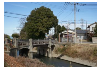
選奨土木遺産に認定されている忍川下流に架かる掘切橋
