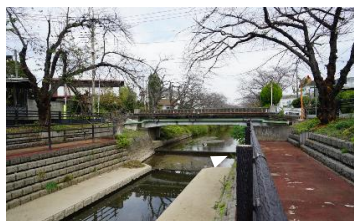
整備された親水護岸（酒巻導水路）
