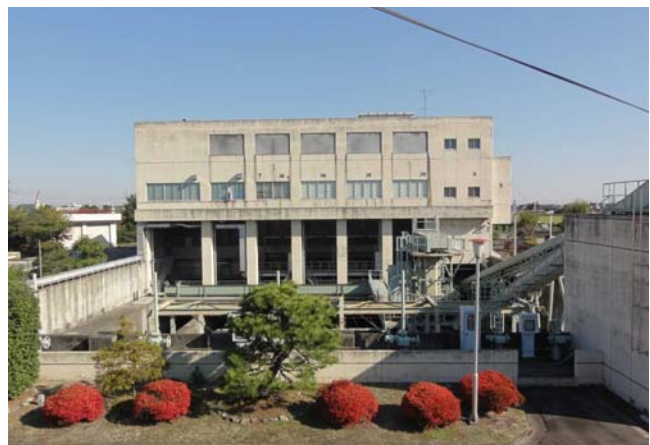
污水中継ポンプ場
