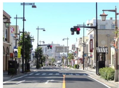
電線類を地中化し、童・銅人形が建つ国道 125 号
