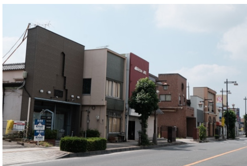
道路に沿って建築物が建ち並ぶことで通りのまち並みが形成される
