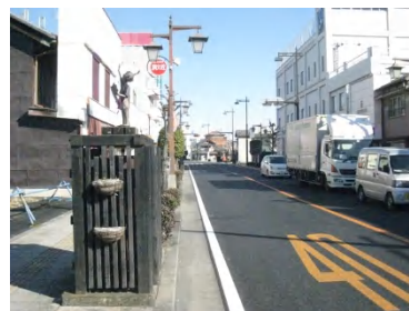
電線類を地中化し、童・銅人形が建つ国道125号
