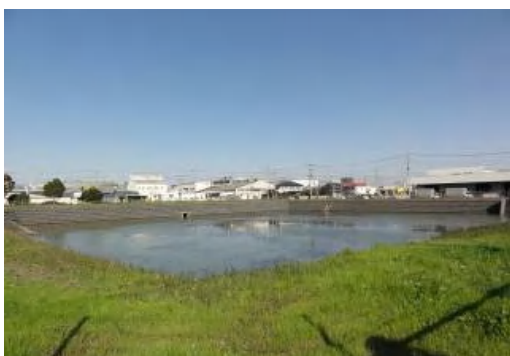
冠水を防ぐ水害からまちを守る調整池
