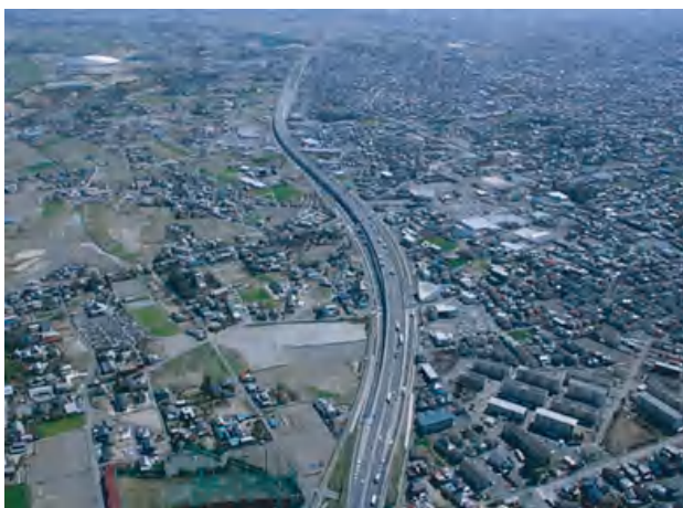
地域高規格道路（国道17号熊谷バイパス柿沼肥塚立体）
