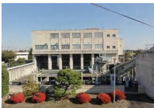
汚水中継ポンプ場
