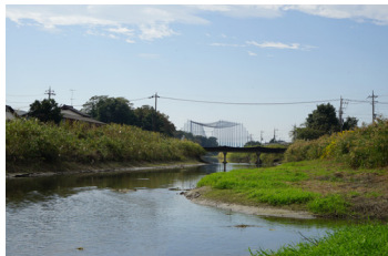
自然環境に配慮した護岸整備がされ、原風景を感じる河川（星川）
