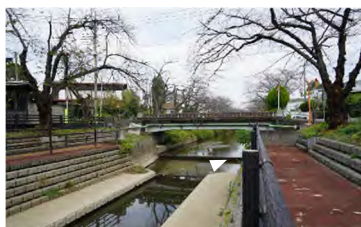
整備された親水護岸（酒巻導水路）
