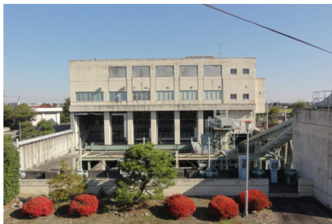
汚水中継ポンプ場
