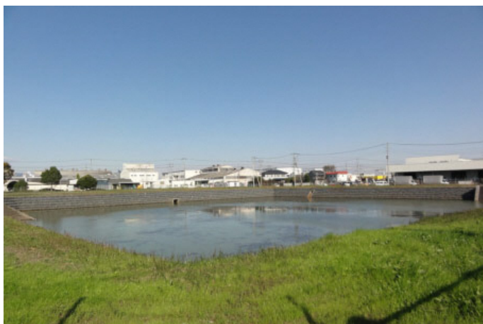
水害からまちを守る調節池
