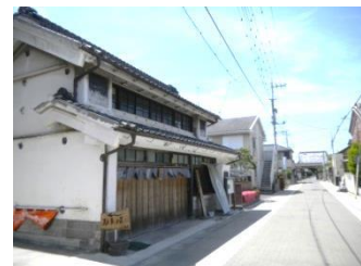
カラー舗装化された蓮華寺通り
