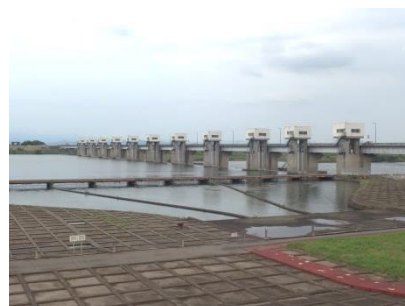
▲利根川と利根大堰
