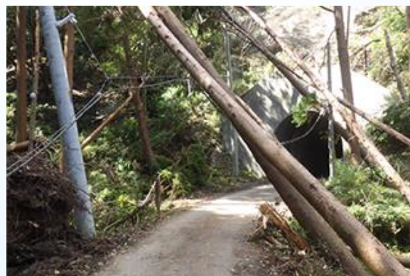
【令和元年 千葉県鴨川市】 ⑦台風第15号 被害状況
