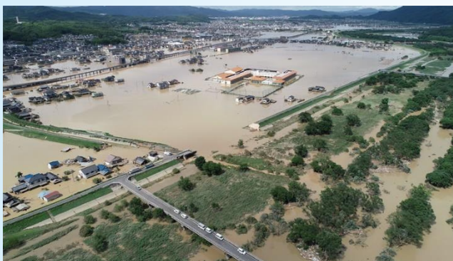
【平成30年7月 岡山県倉敷市】 ④小田川の浸水被害
