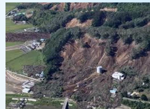
【平成30年 北海道胆振東部地震】 ⑤土砂災害
