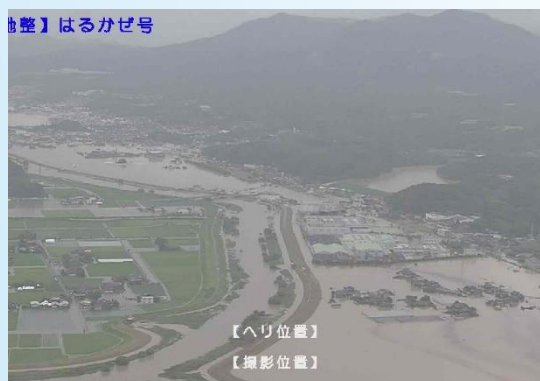
【令和元年8月 佐賀県大町町】 ⑥六角川周辺の浸水被害
