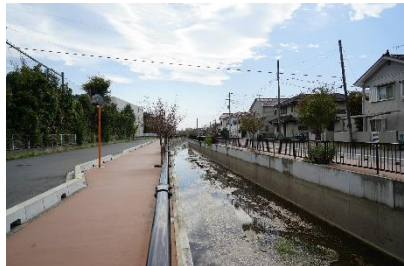
新忍川遊歩道 舗装
