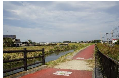
忍川遊歩道 舗装
