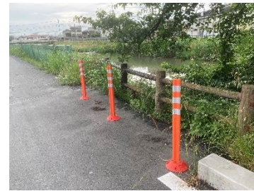
新忍川 転落防止柵
