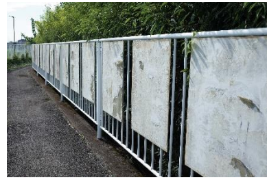
利根大堰周辺 転落防止柵
