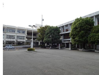
行田市産業会館と地方庁舎
