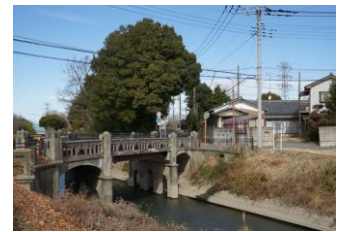
推奨土木遺産に認定されている忍川下流に架かる堀切橋
