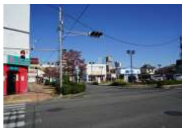
秩父鉄道行田市駅周辺 一部に高彩度色を使用した壁面や規模の大きな広告物が見られる
