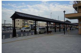
整備された駅前ロータリー
