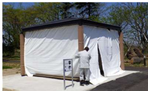
【例②】災害時に個室テントになる 屋根施設 (防災パーゴラ)
