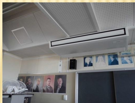
※写真は星宮小学校 （平成26年度工事実施）
