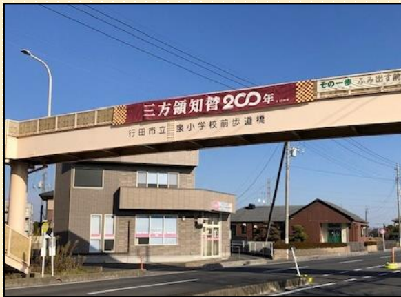
▼ 泉小学校前歩道橋
