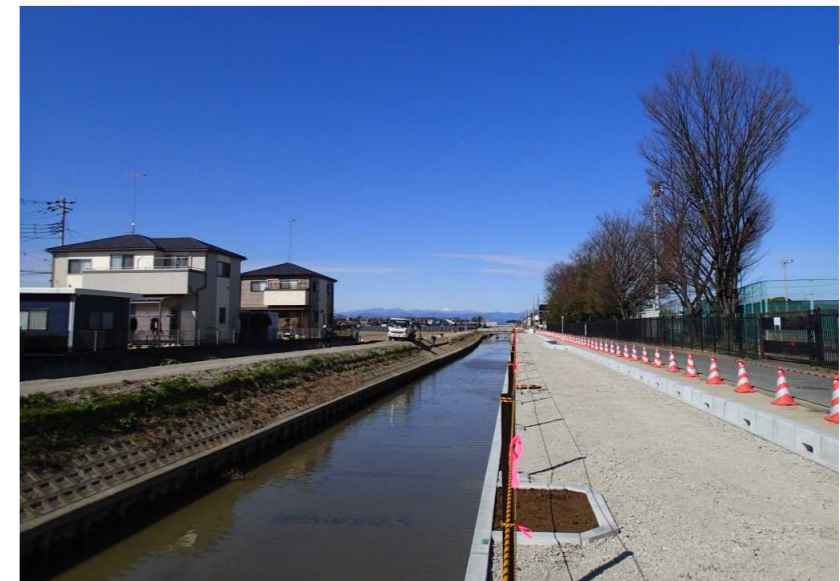
工事進捗状況 (令和2年3月3日現在)
