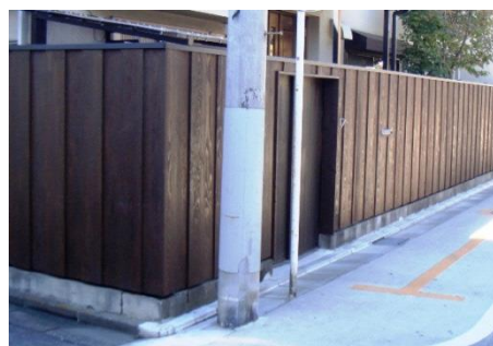
塀の改修（新設）
