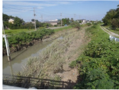
○八幡橋の下流
