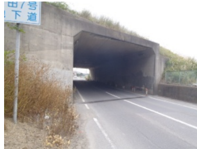
○行田 7 号地下道
