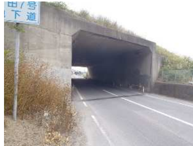
○行田 7 号地下道
