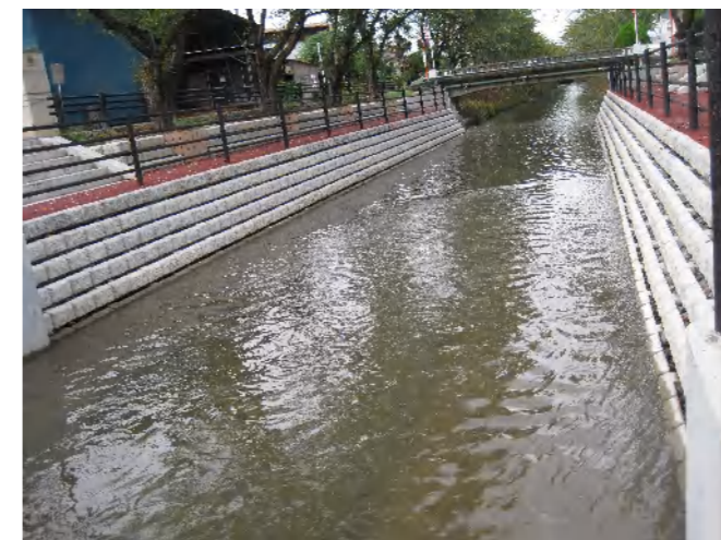
アンカー式護岸イメージ
