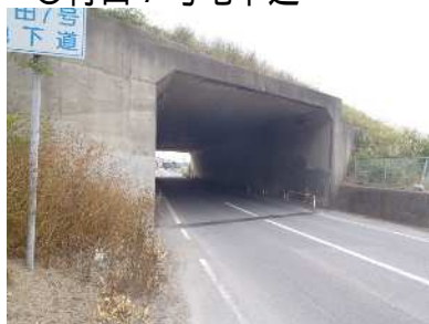
○行田7号地下道
