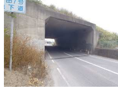
○行田7号地下道
