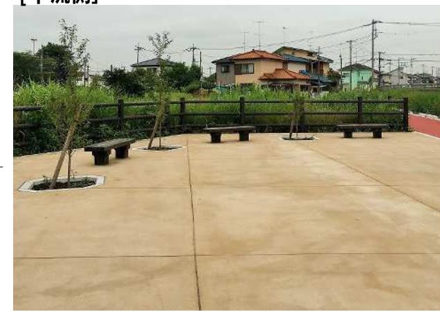
〇皿尾橋の下流 [下流側]
