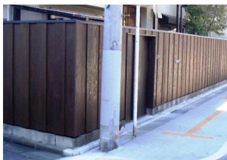
塀の改修（新設）
