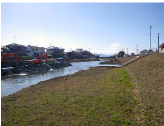
馬見塚橋下流より上流側を望む
