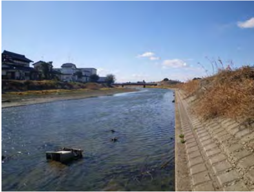
荒木取水ポンプ所付近より上流側を望む
