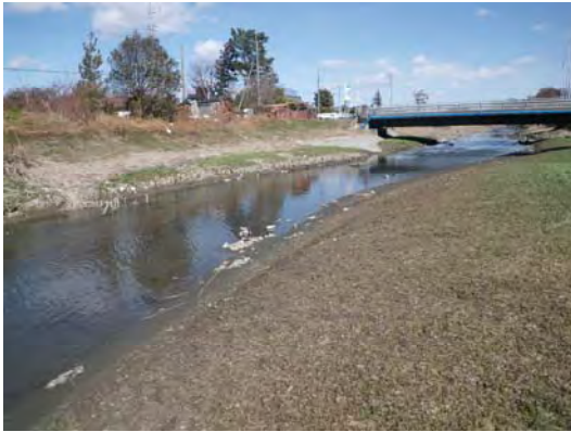
星川橋上流右岸より下流側を望む
