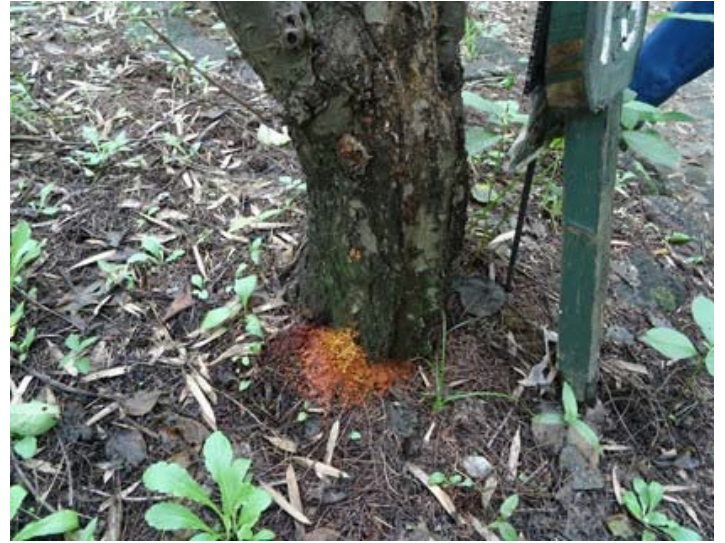
図26 ウメの幹から排出されたフラス
