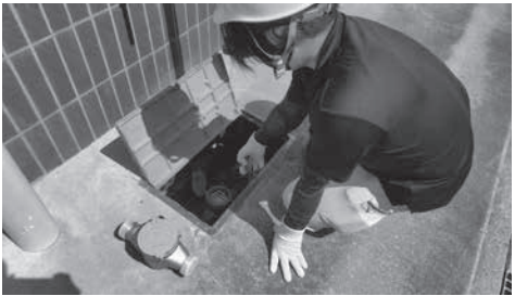
(参考) メーター交換の様子
