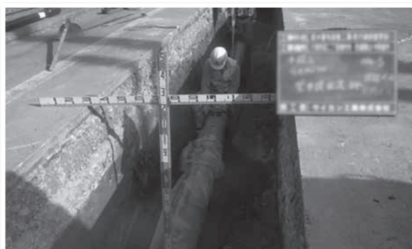
新しい耐震管の布設工事の様子
