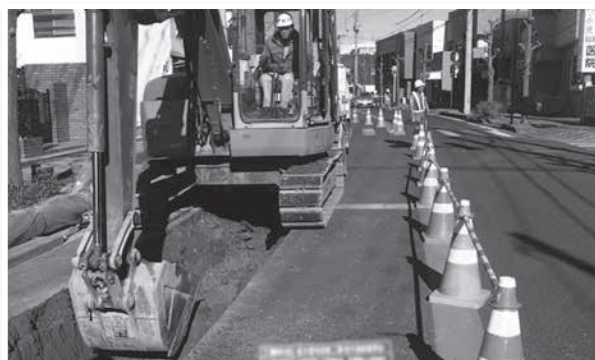
老朽管の掘削・撤去工事の様子
