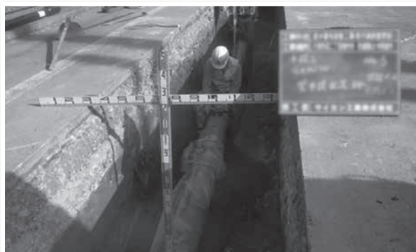
新しい耐震管の布設工事の様子
