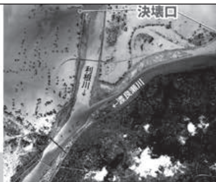
破堤箇所の航空写真
