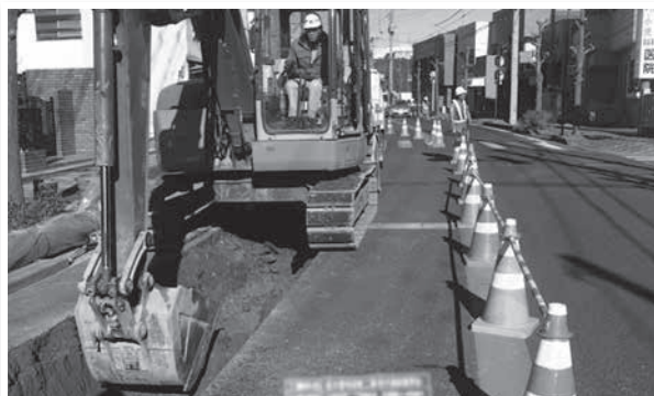
老朽管の掘削・撤去工事の様子
